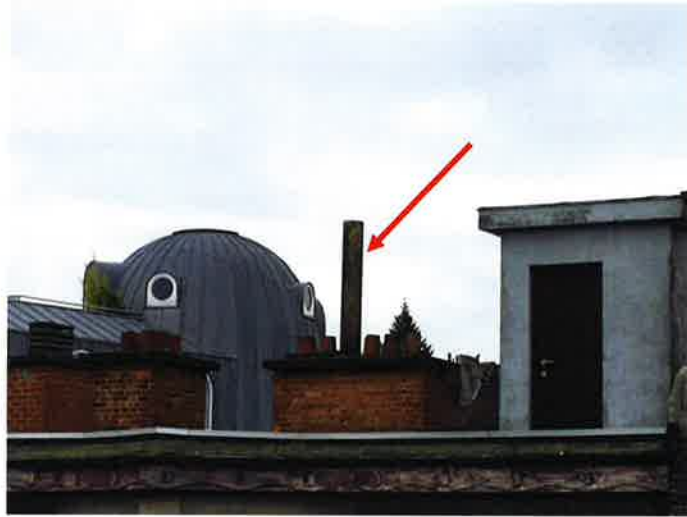
Photos 1 et 2: Gaine amiante-ciment
