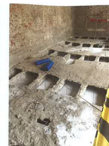
Afb. 8 Zwembad van Sint-Joost-ten-Node: versterking boven de generieke betonplaten [2018 © AAC architecture].
