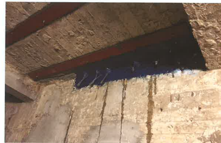
Afb. 7 Zwembad van Sint-Joost-ten-Node: injecties met epoxyhars en versterking met stalen platen van de bodemplaat van de kuip [2018 © AAC architecture].
